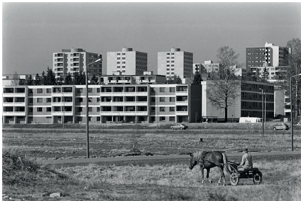
Havukosken lähiö rakennettiin Koivukylän pientaloalueen läheisyyteen 1970-luvulla. Havukoski on Vantaan ensimmäinen lähiö, joka on suojattu asemakaavassa. Kuva: Matti Luumi / Vantaan kaupunginmuseo.
